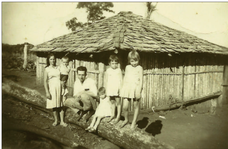
FIGURA 06 - Residência construída com madeira de coqueiro
