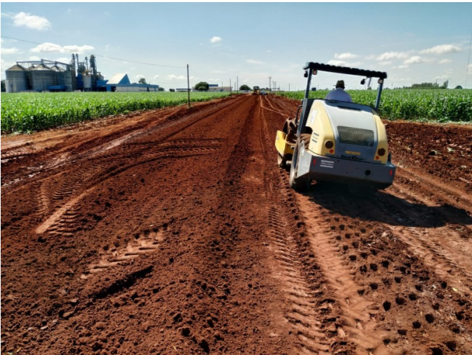
Figura 5: Compactação com rolo da estrada
