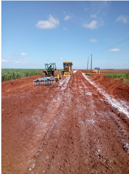
Figura 3: Incorporação do produto na camada de 20 cm
